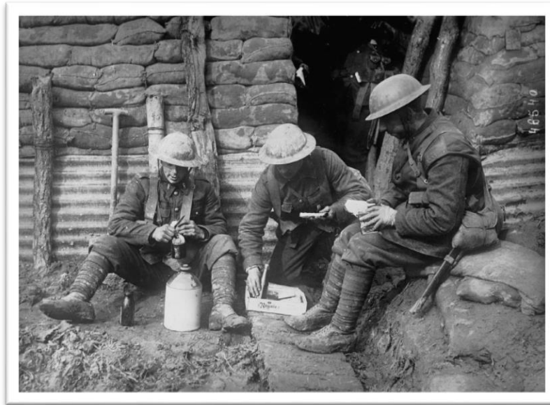
Les canadiens dans les tranchées qui prennent un repos et des boissons (pris du Bibliothèque Nationale de France).
