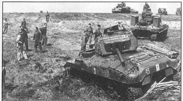
Un Ram [VBR] Mk I récupère un Ram II de la 5 e Div. bl. can. embourbé, en Angleterre en mai 1943. (ANC, PA 192268)
